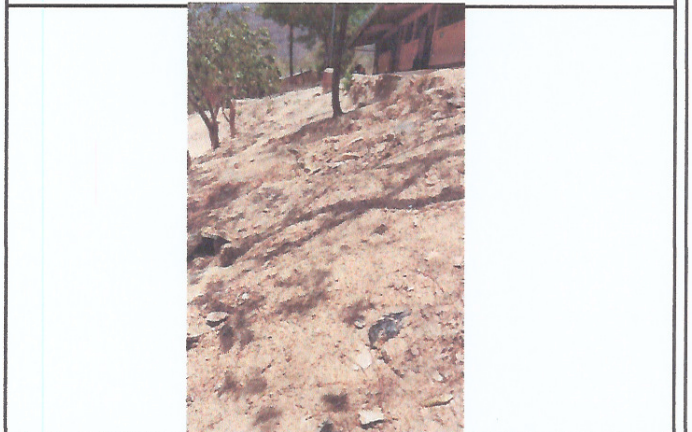
Foto 4: Area donde se contempla hacer el mejoramiento de cerramiento de muro perimetral.
