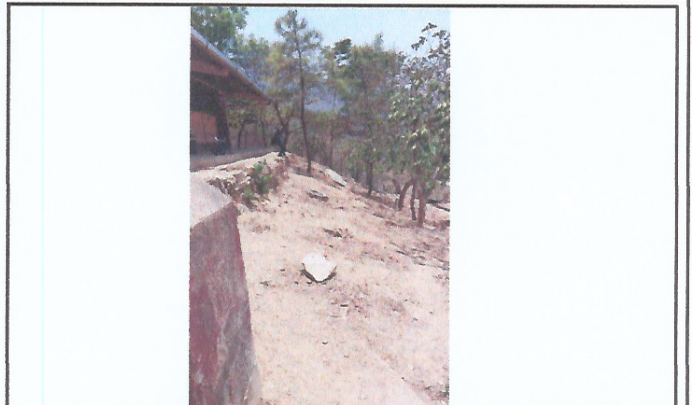
Foto 2: Area donde se contempla hacer el mejoramiento de cerramiento de muro perimetral.
