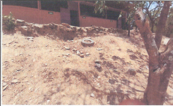
Foto 1: Area donde se contempla hacer el mejoramiento de cerramiento de muro perimetral.
